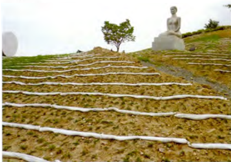
유기질 퍼달라이즈 설치모습
